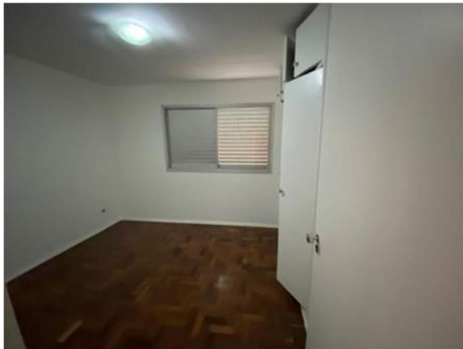
VISTA DO PADRÃO CONSTRUTIVO DO DORMITÓRIO.
