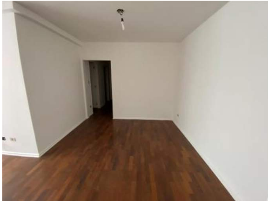
VISTA DO PADRÃO CONSTRUTIVO DA SALA DE JANTAR.
