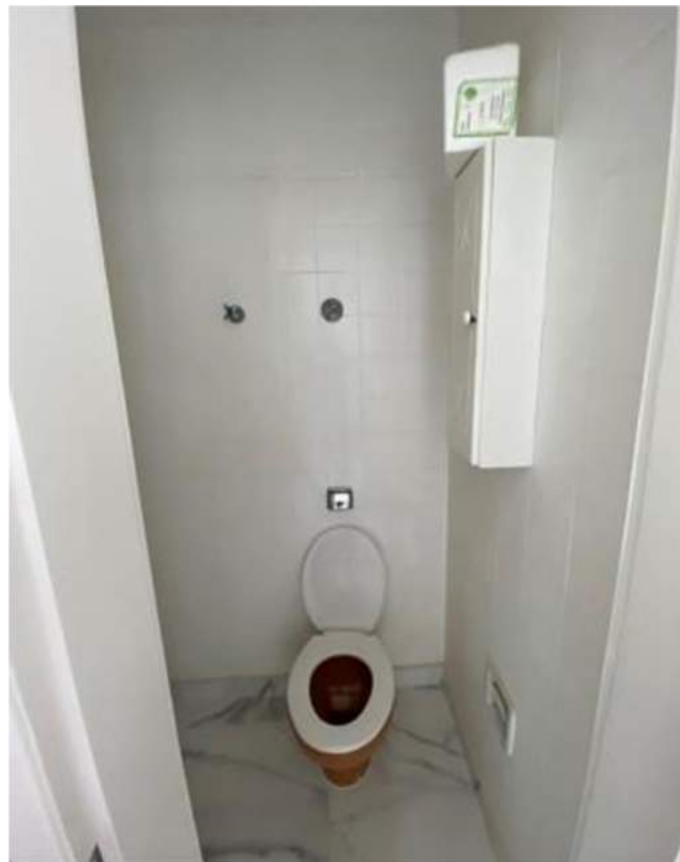
VISTA DO PADRÃO CONSTRUTIVO DO BANHEIRO.
