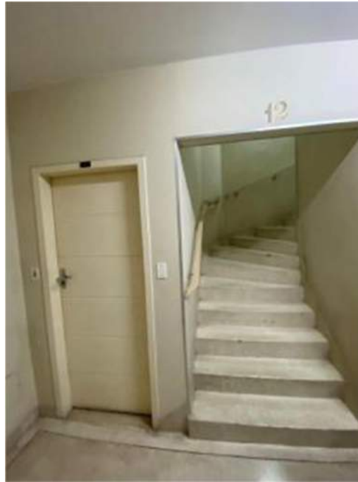
VISTA DA ENTRADA DE SERVIÇO DO IMÓVEL.
