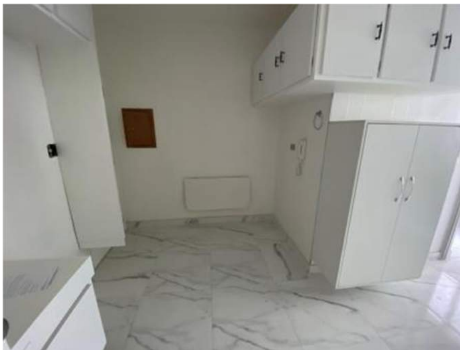
VISTA DO PADRÃO CONSTRUTIVO DA COZINHA.
