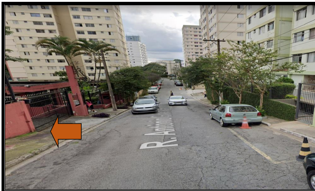
Vista da Rua Antônio Guarmerino com o edifício à esquerda.
