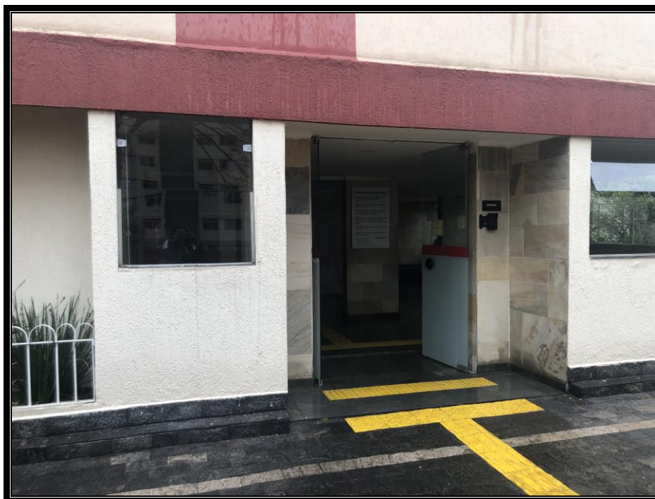
Foto – Vista entrada do edifício Ursa Maior.
