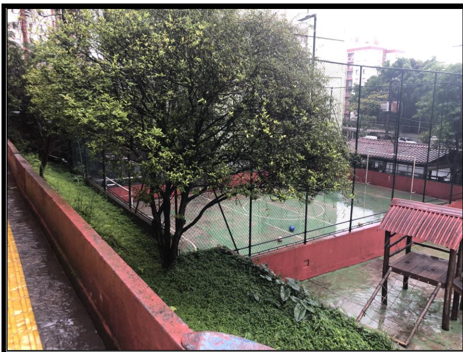
Foto – Vista quadra do edifício, acesso por escada.
