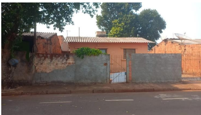
Foto 01: Fachada do imóvel avaliando
