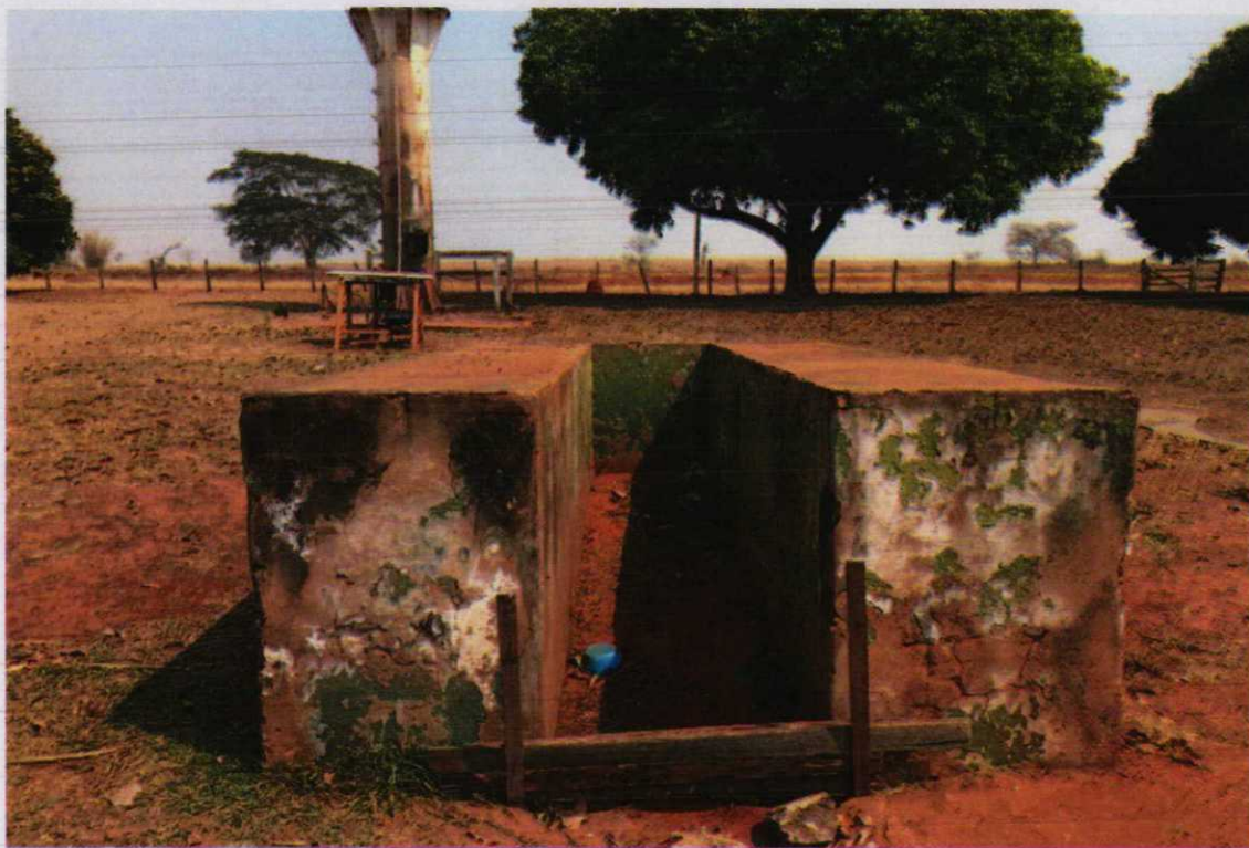
Foto 27 - Vista do lavador de veículos.
