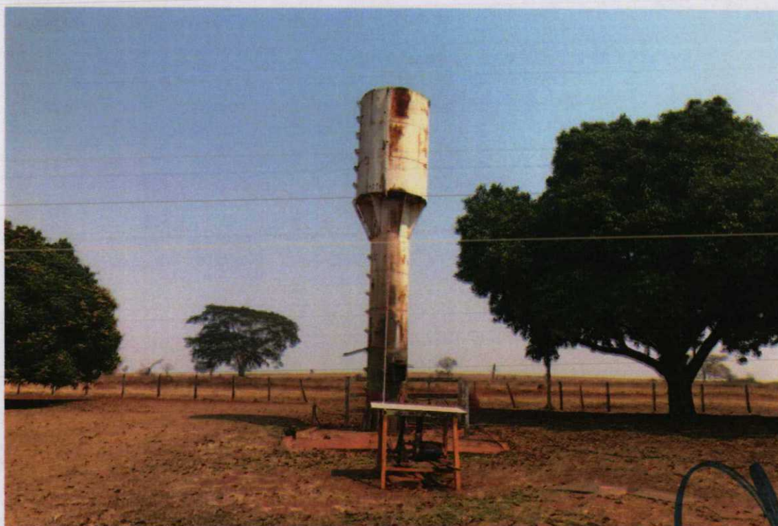
Foto 28 - Vista da caixa d'água.
