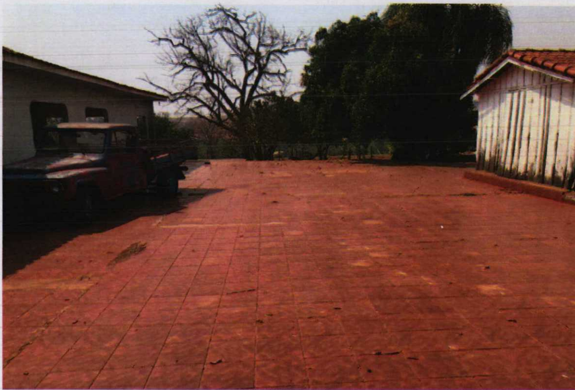
Foto 23 - Vista de área ladrilhada entre a casa sede e a tulha.
