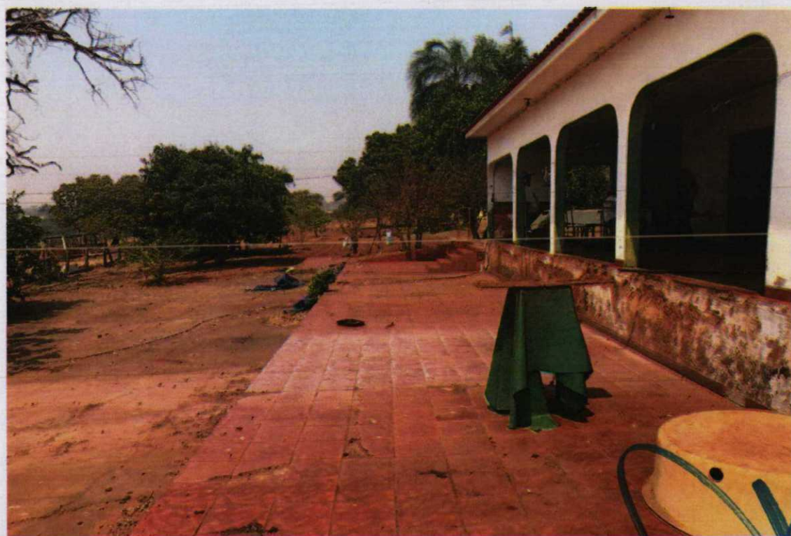
Foto 22 - Vista de área ladrilhada aos fundos da casa sede.
