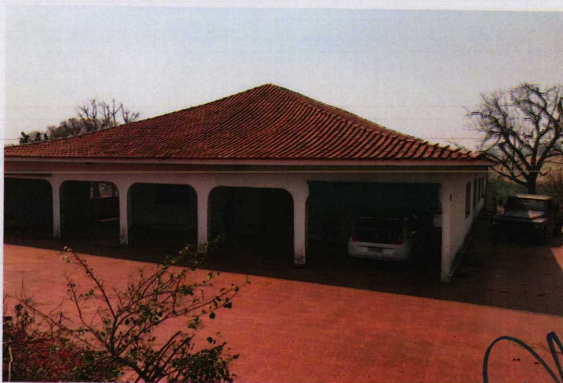
Foto 04 - Outra vista da casa sede.
