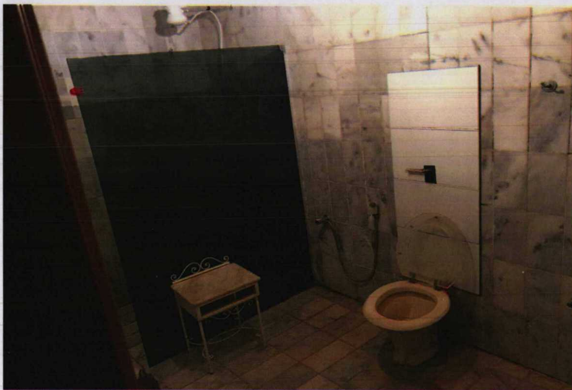
Foto 15 - Vista do banheiro da suíte.
