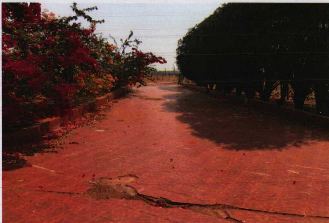
Foto 19 - Vista da entrada de veículos ladrilhada da casa sede.
