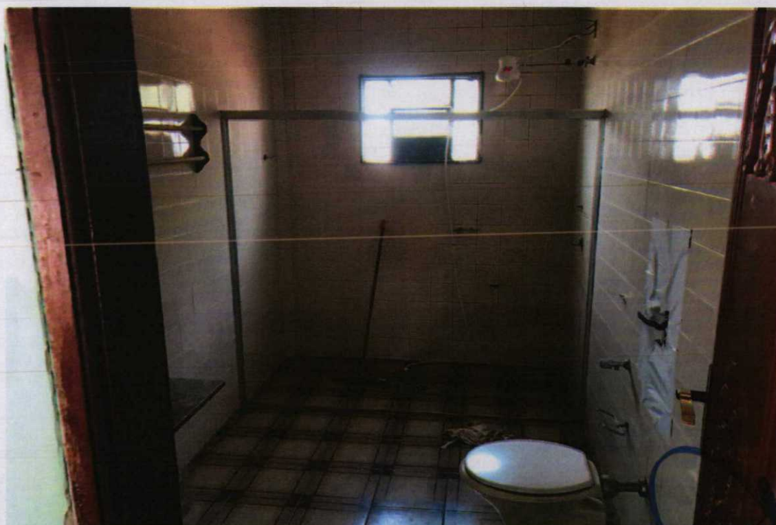
Foto 32 - vista do banheiro da casa próxima a casa sede.
