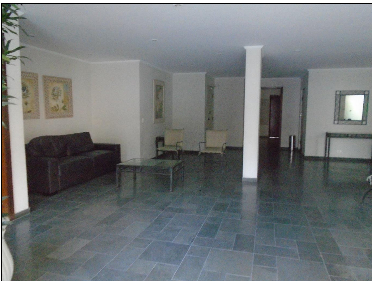
FOTO 11 - APECTO DOS MATERIAIS DE REVESTIMENTO EM PEDRA NATURAL DO PISO.
