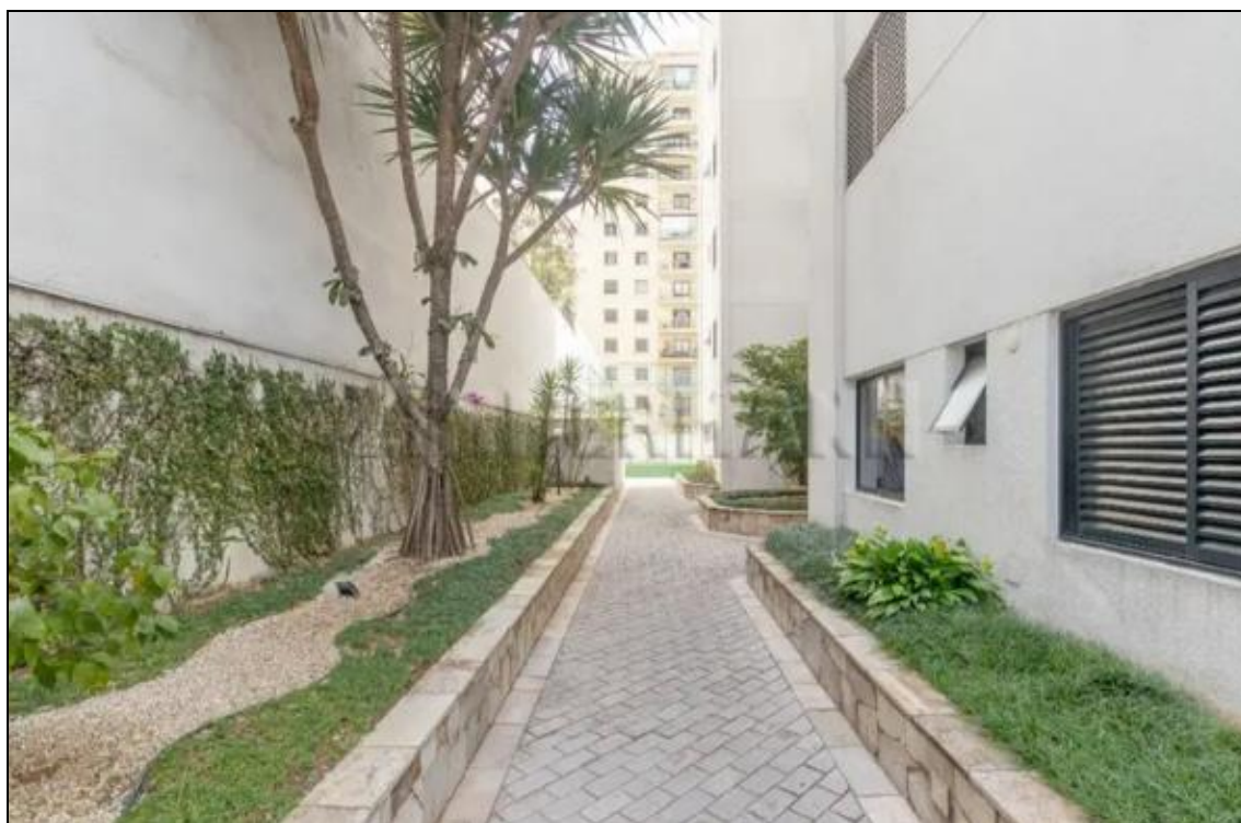
FOTO 18 - ASPECTO DOS MATERIAIS DAS ESQUADRIAS EM ALUMINIO ANODIZADO PRETO.
