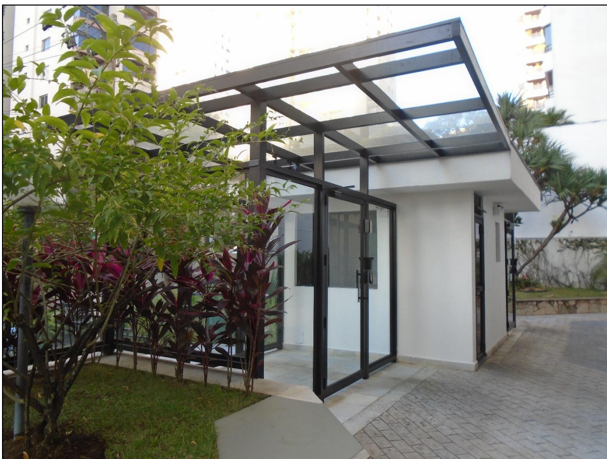
FOTO 05 - ESTRUTURA METÁLICA COM PAINEIS VIDRO JUNTO ENTRADA SOCIAL E SERVIÇO.
