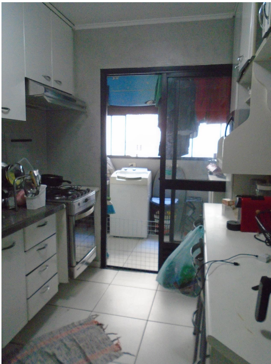
FOTO 08 – NECESSIDADE SUBSTITUIÇÃO TACOS DANIFICADOS POR IFILTRAÇÃO.
