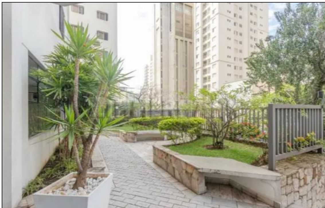
FOTO 17 - ASPECTO DOS MATERIAIS DE REVESTIMENTO EM PEDRA NATURAL DO PISO.
