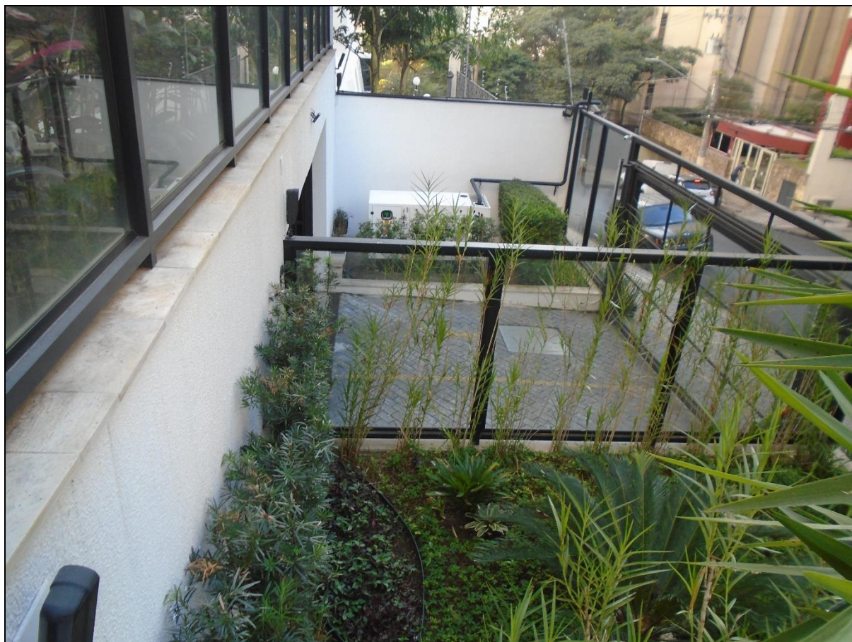
FOTO 08 - ASPECTO DOS ELEMENTOS DE PAISAGISMO E DIVISÓRIAS COMPOSTAS DE PAINÉIS DE VIDRO..
