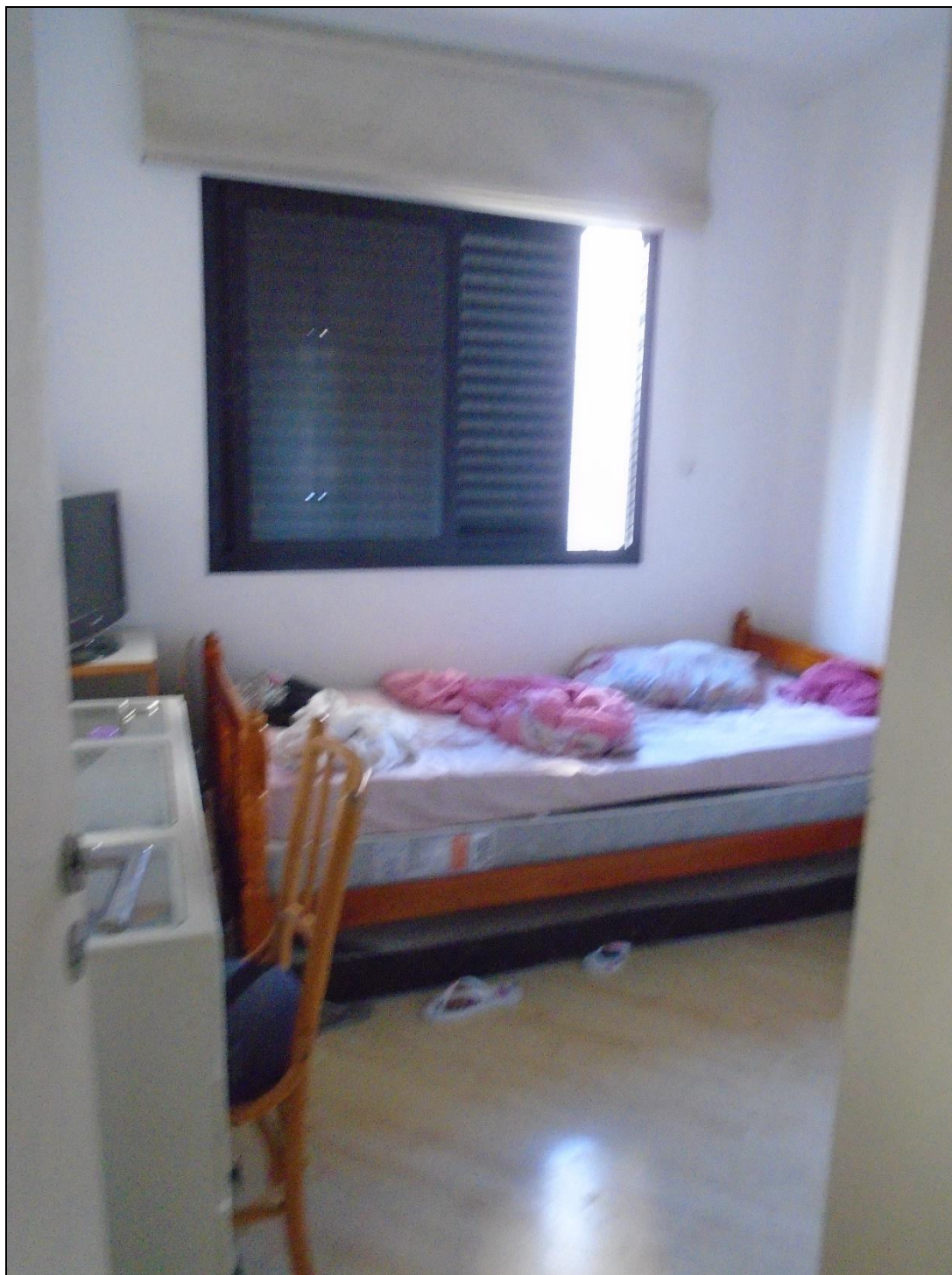
FOTO 08 – NECESSIDADE SUBSTITUIÇÃO TACOS DANIFICADOS POR INFILTRAÇÃO.
