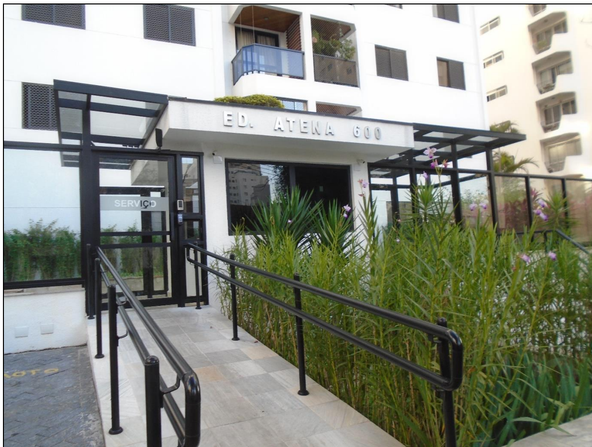
FOTO 07 - RAMPA DE ACESSO COM GUARDA CORPO .
