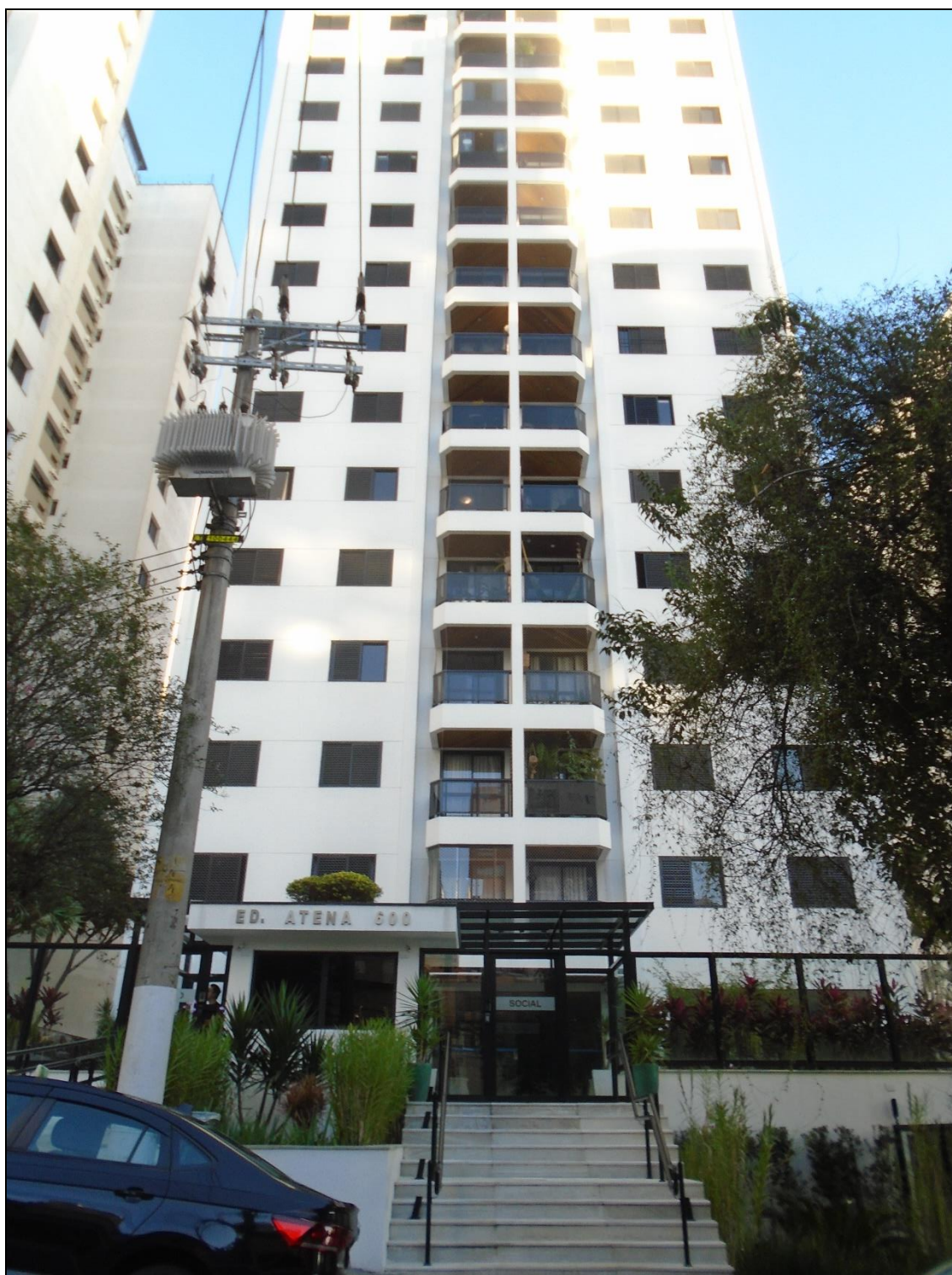
FOTO 04 - FACHADA FRONTAL DO PRÉDIO COM TERRAÇOS.
