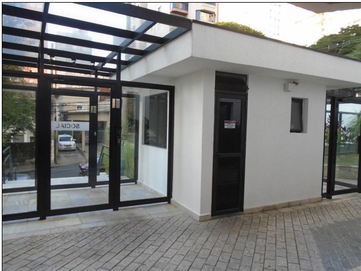
FOTO 06 - PORTARIA COM EQUIPE DE SEGURANÇA E SISTEMAS MONITORAMENTO CFTV.
