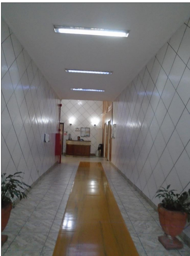
FOTO 02 – ASPECTO DO HALL ACESSO ELEVADOR .
